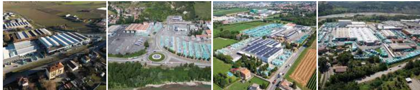
Dado Ceramica Uffici e Stabilimento Produttivo (Offices and Production Plant)
